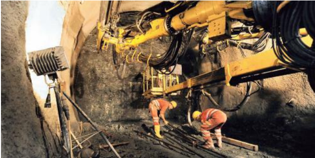
Bauarbeiten im Erkundungsstollen
